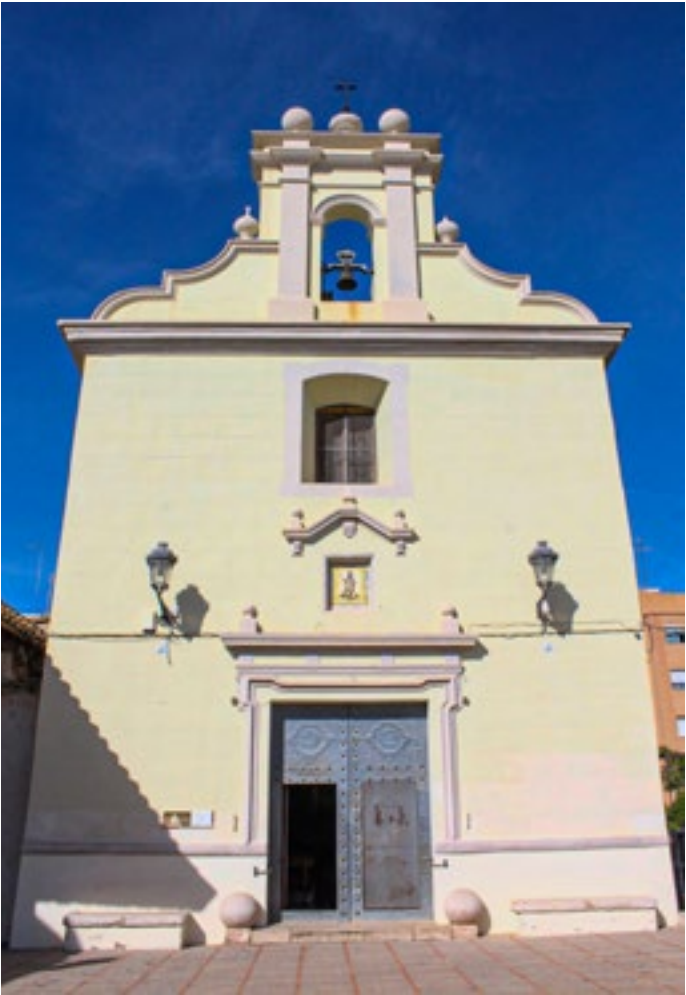
Façana principal de l'ermita de Sant Roc. En la part superior de la porta es pot observar una representació en ceràmica del sant
