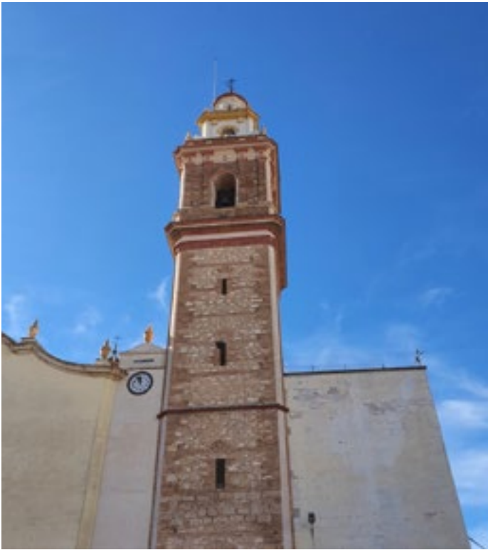
La Torre Campanar
