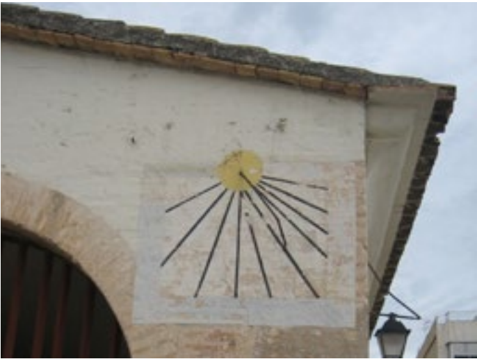
Rellojge de sol pintat en els laterals de l'Embaronat de la dreta
