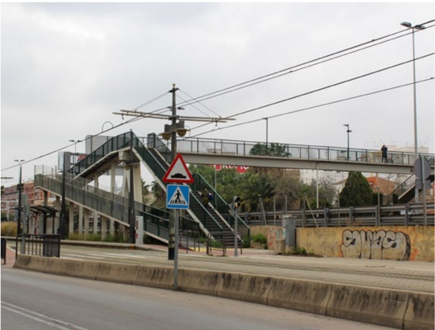
Avinguda de la Mare de Déu de la Cabeça
