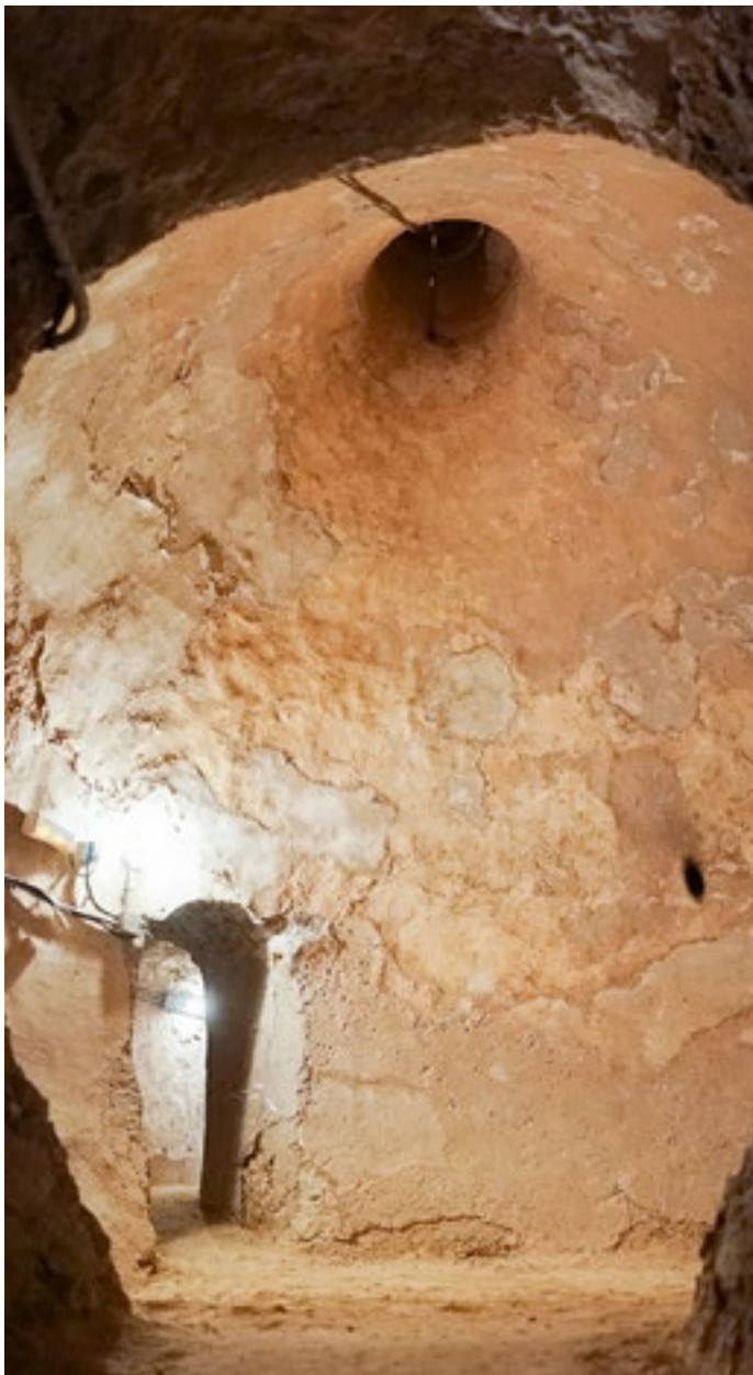
Vista interior d'una de les sitges, en la qual s'aprecia la boca per on s'introduïa el blat
