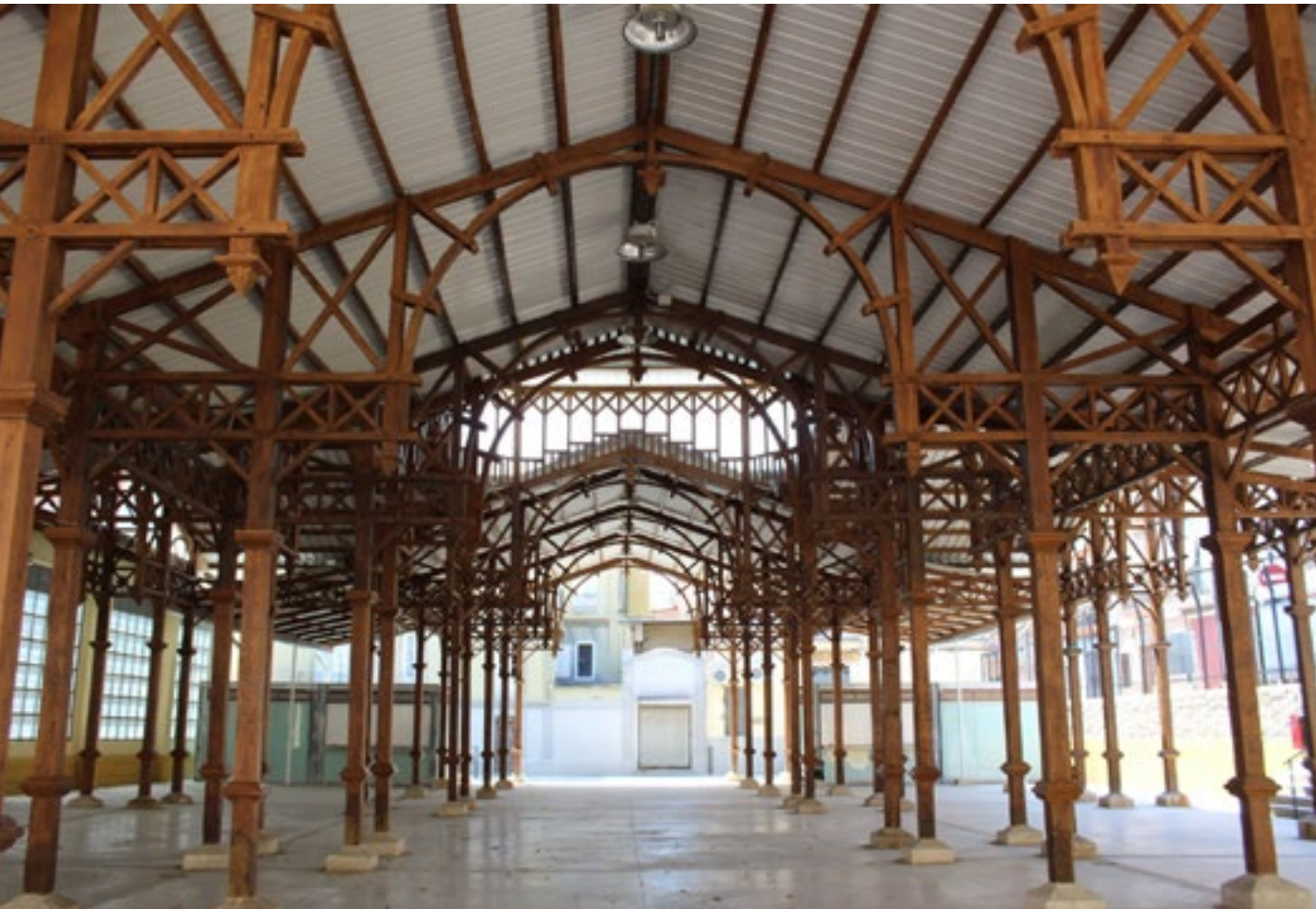
Vista general de l'estructura interior
