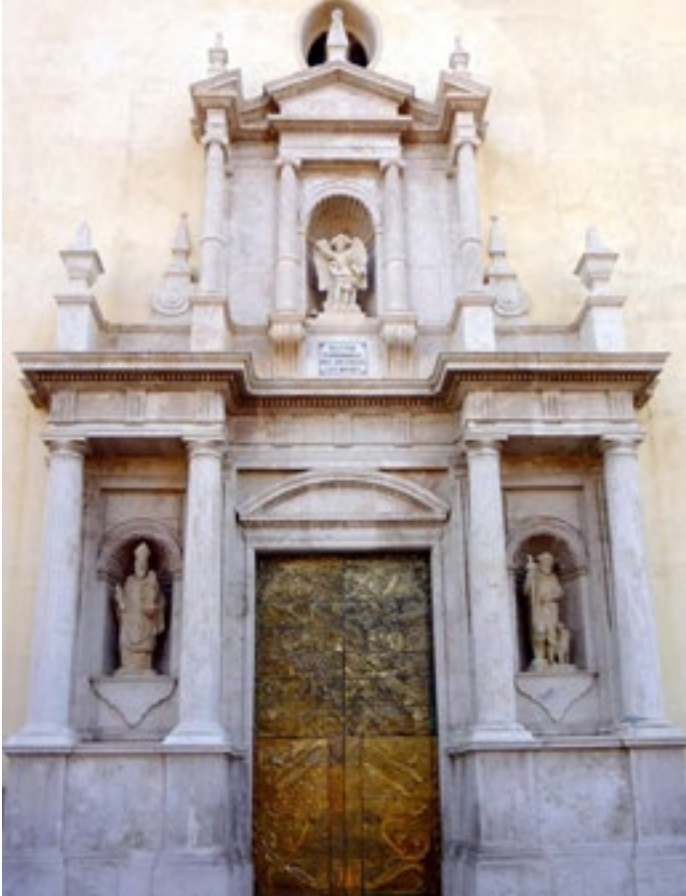
Accés principal de l'església abans i després de la seua restauració. En els laterals de la porta trobem a Sant Joan de Ribera (esquerra) i a Sant Roc (dreta). I presidint el conjunt arquitectònic ornamental el titular Sant Miquel Arcàngel (Foto: P. Arnau).
