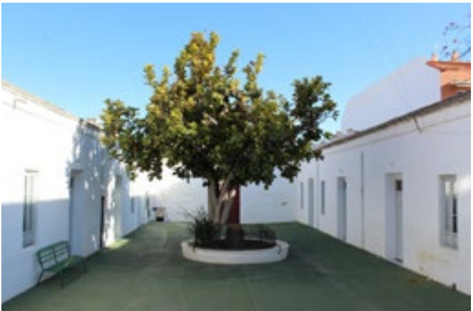
Pati interior de l'antiga caserna de la Benemèrita
