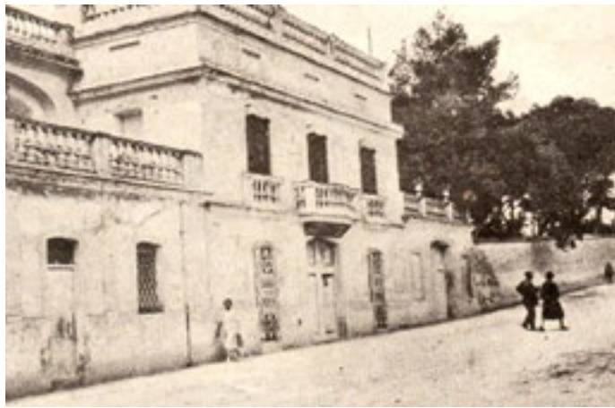
Edifici original de la Llar-Residència Sequera, abans del seu enderrocament
